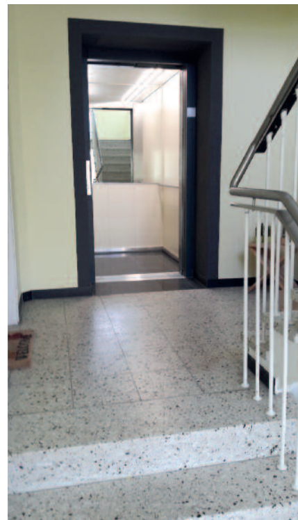
Ladenburg, Merianweg 12, Aufzugsanlage
